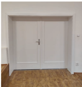
Nové dveře v tělocvičně v Leskovci
