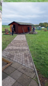
práce na pokládce zámkové dlažby
