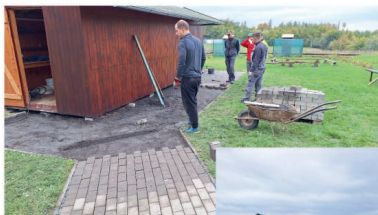
práce na pokládce zámkové dlažby
